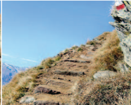
Der sanierte Weg
