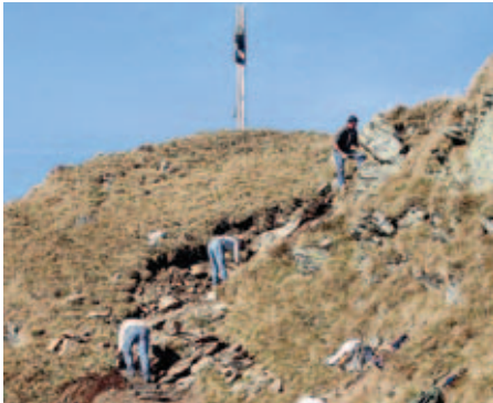
Bei der Sanierung des Jaufenkamms
